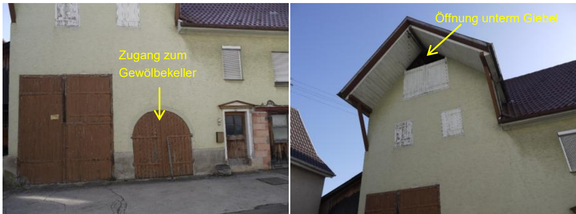
Abb. 5: Westseite des Gebäudes mit Zugang zum Gewölbekeller und Öffnung am Giebel
