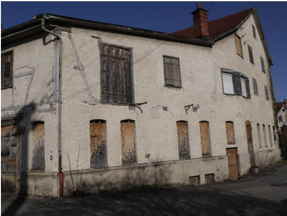
Abb. 4: Die östliche Gebäudeseite liegt entlang dem Gewässer „Lauter“
