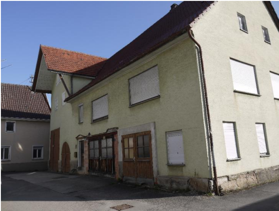
Abb. 3: Blick von der Amtstraße auf die westliche Seite des Gebäudes
